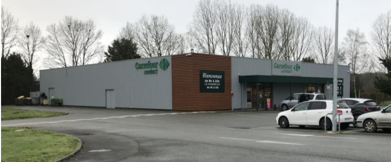
Des enseignes commerciales existent dans les zones UE d'Ons-en-Bray et de La Chapelle-aux-Pots
